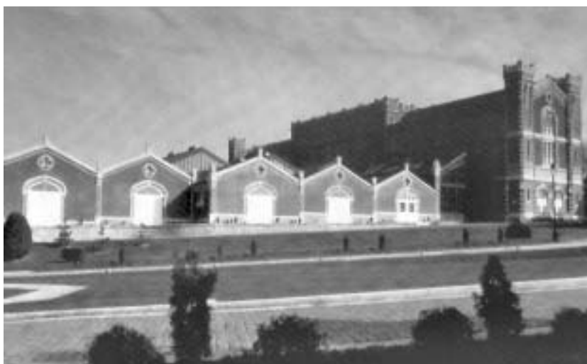
L'entrepôt est devenu la grande cuverie, sans que cela se remarque à l'extérieur de ce beau bâtiment de la fin du XIX siècle.
